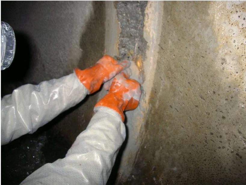
**大口径補修 Y字管工法**
