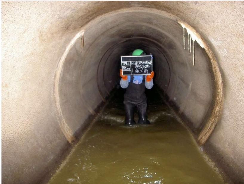
**大口径補修 Y字管工法**
