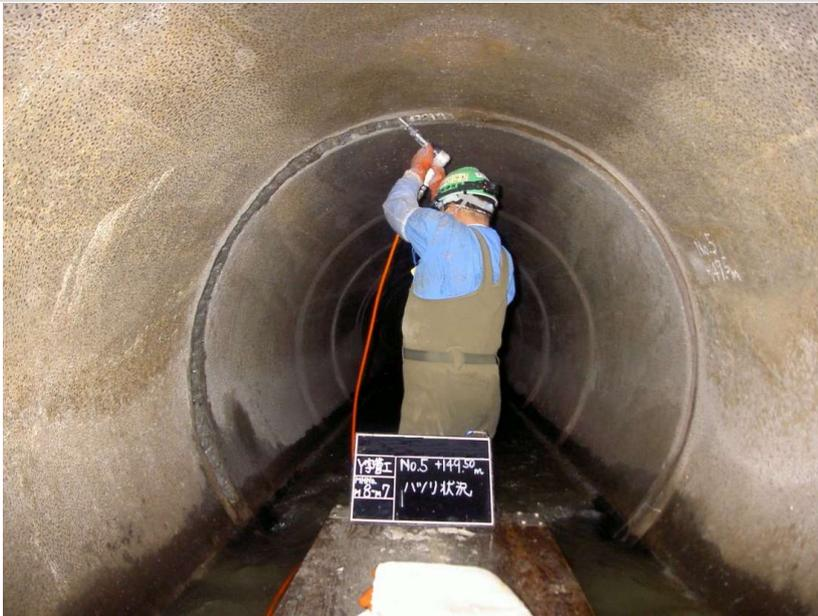
**大口径補修 Y字管工法**
